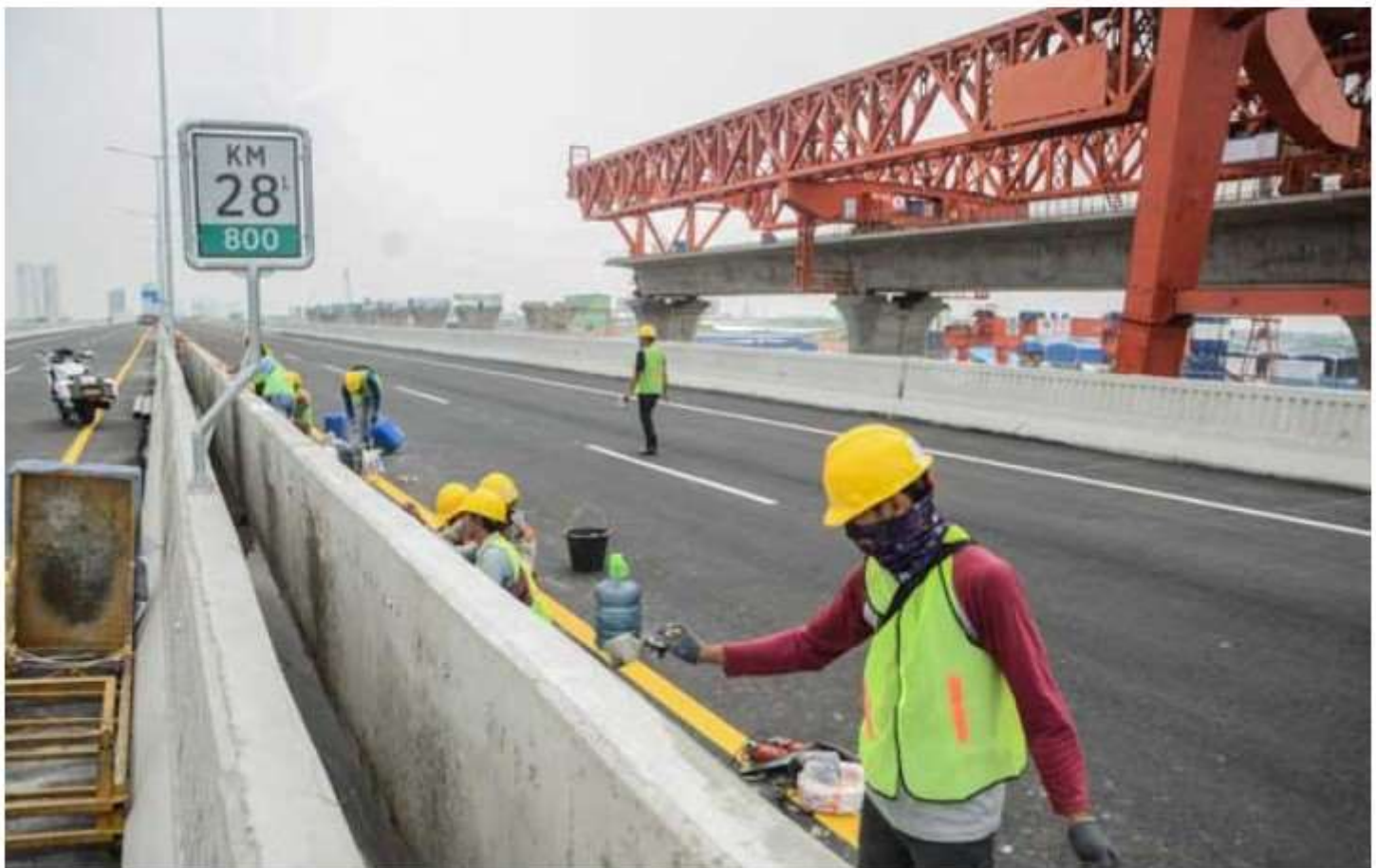
Pekerja menyelesaikan proyek jalan tol layang Jakarta-Cikampek Km 28, Cikarang, Kabupaten Bekasi, Jawa Barat, kemarin.
