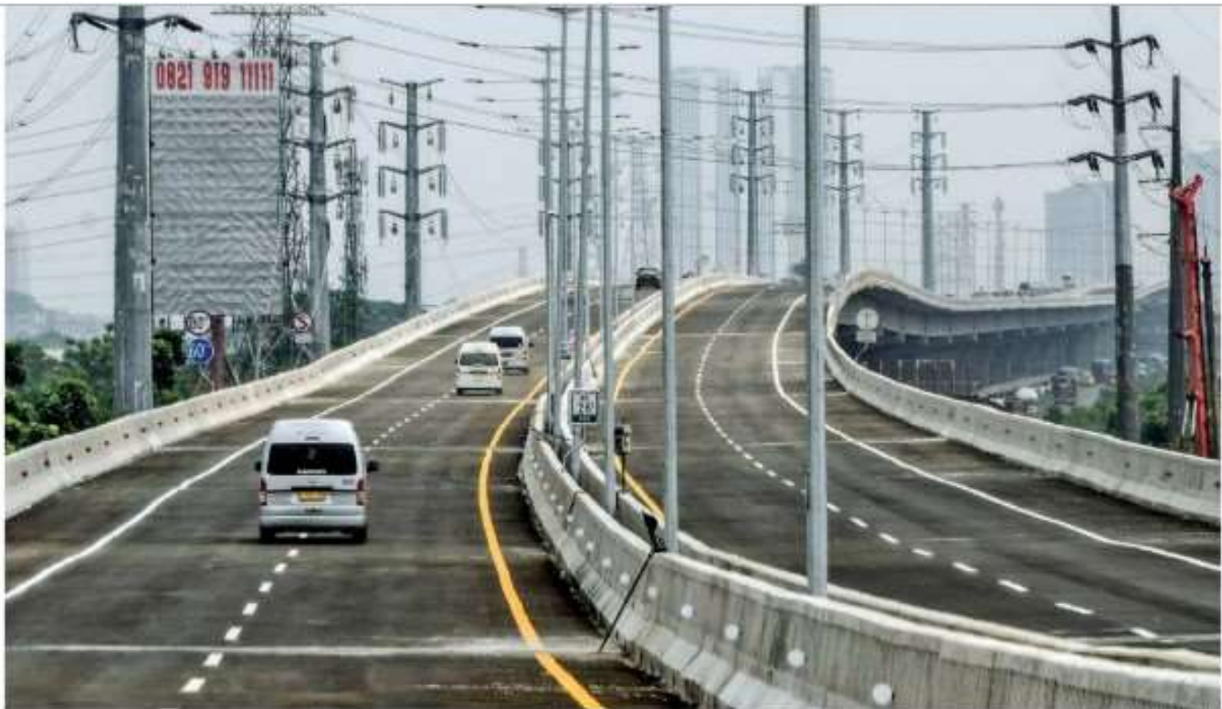
PENGOPERASIAN TOL LAYANG ELEVATED-JAKARTA-CIKAMPEK: Suasana Tol Layang (Elevated) Jakarta-Cikampek Km 28, Cikarang, Kabupaten Bekasi, Jawa Barat, kemarin. Tol Layang sepanjang 38,1 km itu akan beroperasi pada Jumat (20/12) dengan batas kecepatan 60 km per jam dan pengawasan petugas kepolisian setiap 4 km.
